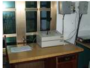
< 指令卓設置状況 >
